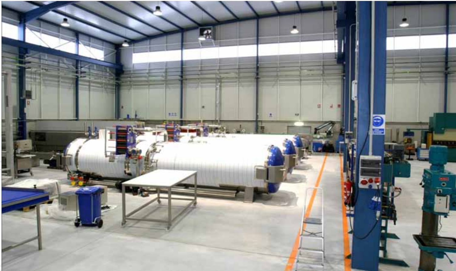
VISTA INTERIOR DE LAS INSTALACIONES
